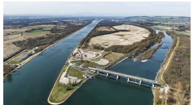
Chantier de la centrale hydroélectrique avant la mise en place des mesures compensatoires (source : EDF)
