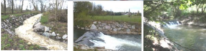
Déversoir et seuil à Manspach
