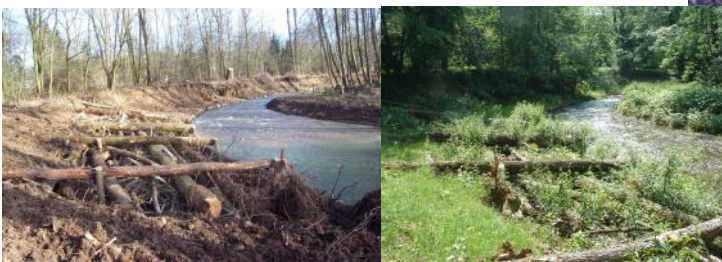
Technique du peigne pour la tenue des berges grâce à leur végétalisation
