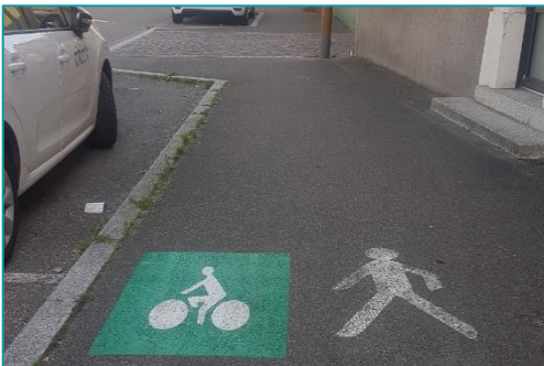
Trottoir partagé rue Braun : cette solution n'est pas adaptée à tous les cas de figure, par exemple en cas de forte affluence piétonne et cycles, sauf à adapter la largeur des trottoirs en conséquence.
