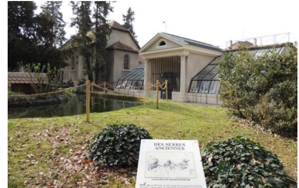
Les anciennes serres restaurées
