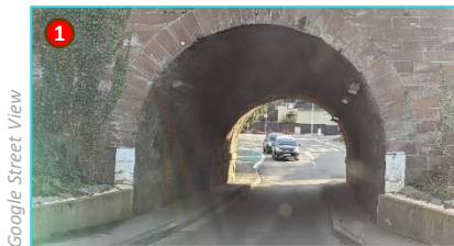
Rue Wilson Une voie, circulation alternée
