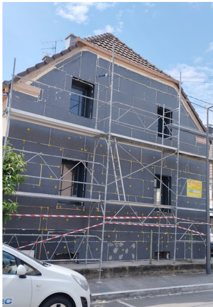
Isolation par l'extérieur, Wittenheim
