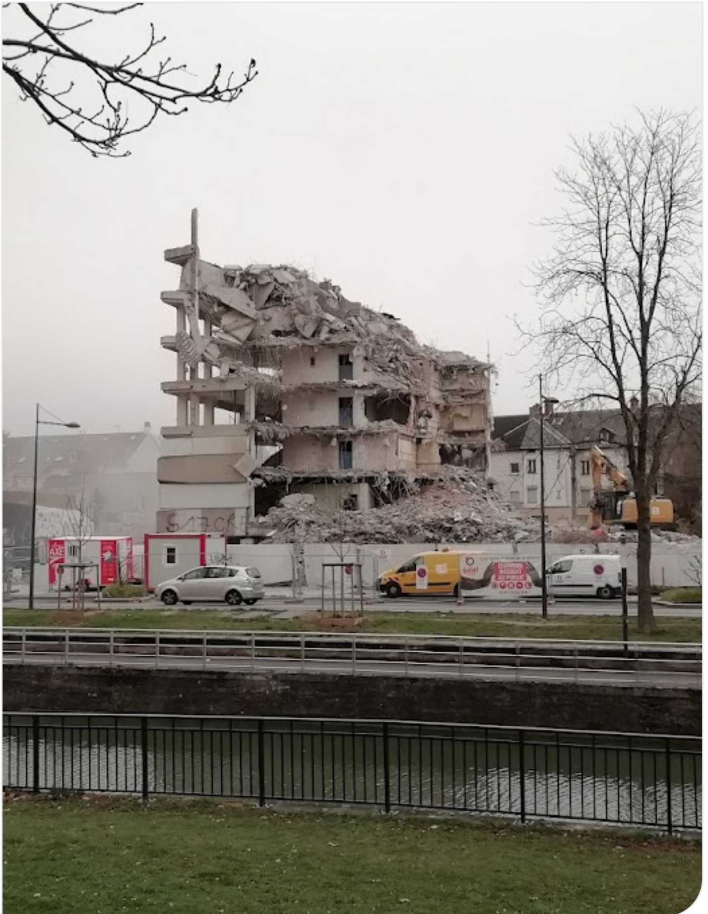
Démolition du foyer les Marronniers, Mulhouse 2022
