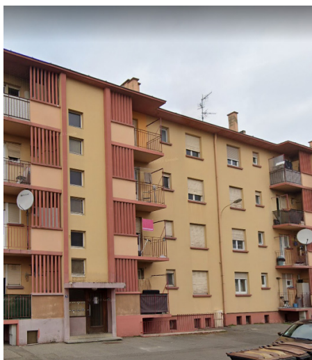
Résidence Dunkerque St Malo- Rue de Dunkerque, Mulhouse
