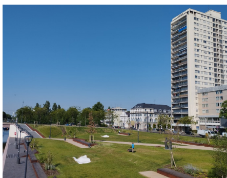
Aménagement parc de la gare de Mulhouse pour une meilleure qualité de vie, 2023
