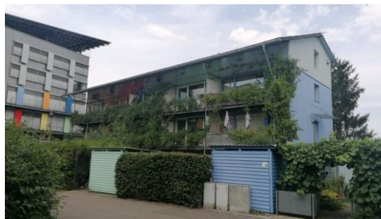
De petits immeubles intermédiaires ici à l'écoquartier Vauban à Freiburg en Allemagne, ces typologies intermédiaires en R+2 permettent de proposer des jardins individuels à des résidents vivant en appartement
