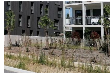
Pieds d'immeubles de l'écoquartier de Reichstett (67)
