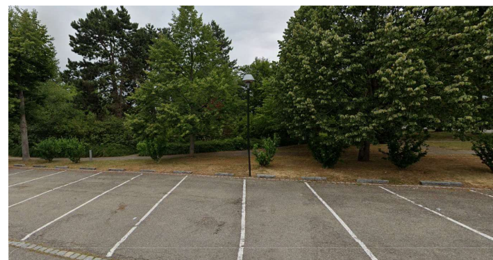
Boisements du talus se sont trop développés (buissons type cornouillers sont maintenant des arbustes)
