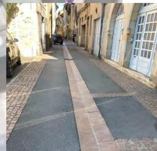
Exemple de zone de rencontre. Une solution avec la majorité des surfaces en enrobé permet de réduire le coût tout en soulignant façades et axe de circulation par un traitement plus qualitatif en pavés. Source image Mairie de Figeac (46)
