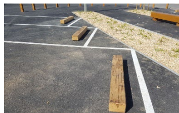
Butte-roues pour protection des arbres sur la rangée centrale
