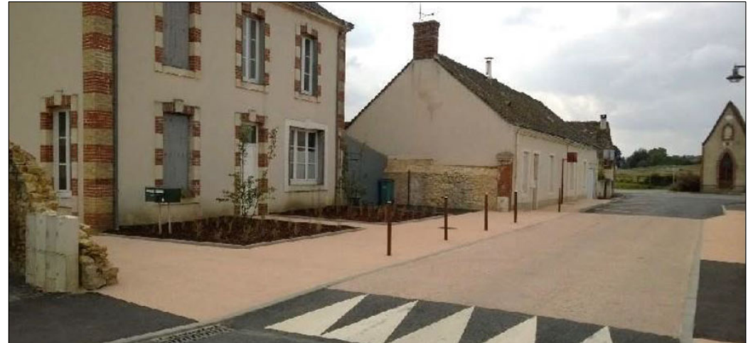
Source : webinaire CEREMA -17 06 2021, Soulitré
