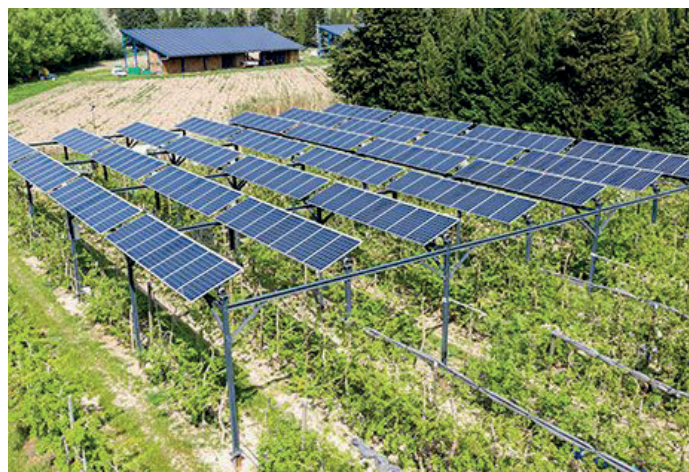
L'agrivoltaïsme, une technologie qui protège les cultures agricoles des aléas climatiques, tout en produisant de l'énergie Source : monviti.com
