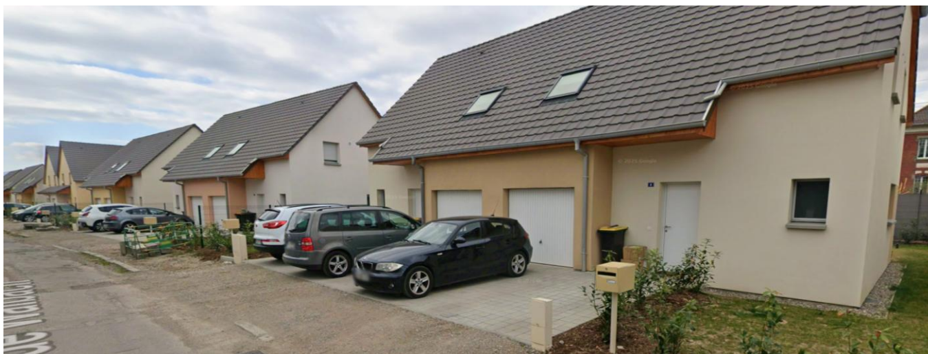
Rue de Walbach, Mulhouse, opération en LLI de 14 maisons groupées, DOMIAL
