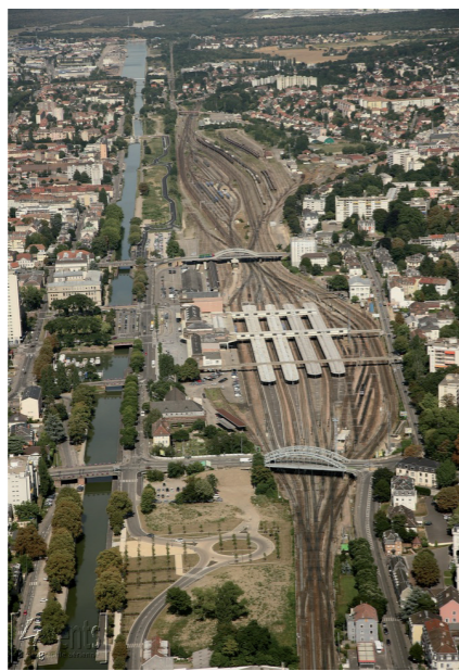
Vue aérienne du site de la gare
