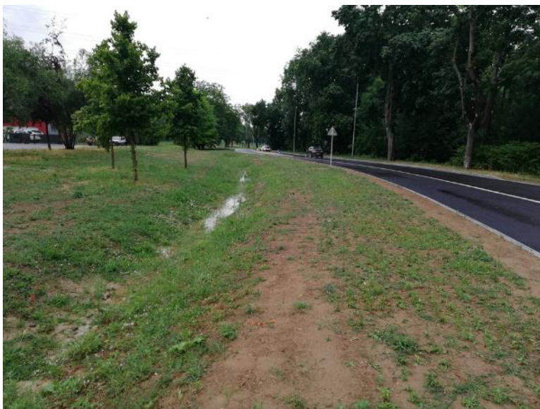
Noue d'infiltration, Brunstatt-Didenheim
