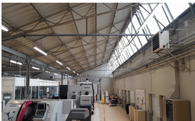
Bât.C partie Atelier : Génie Mécanique et Productique
