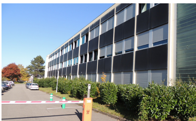
Bât.D : Restaurant universitaire, Gestion des Entreprises et des Administrations
