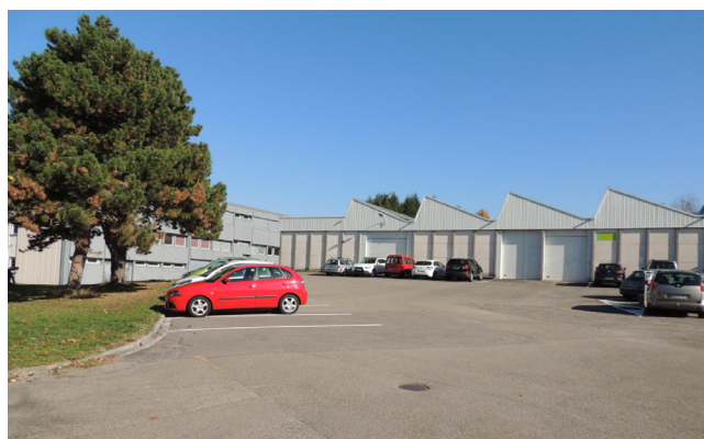
Bât.C Atelier : Génie Mécanique et Productique
