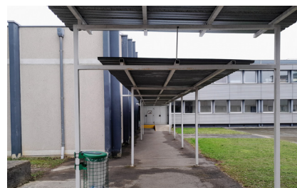
Coursives extérieures couvertes qui relient les bâtiments entre eux
