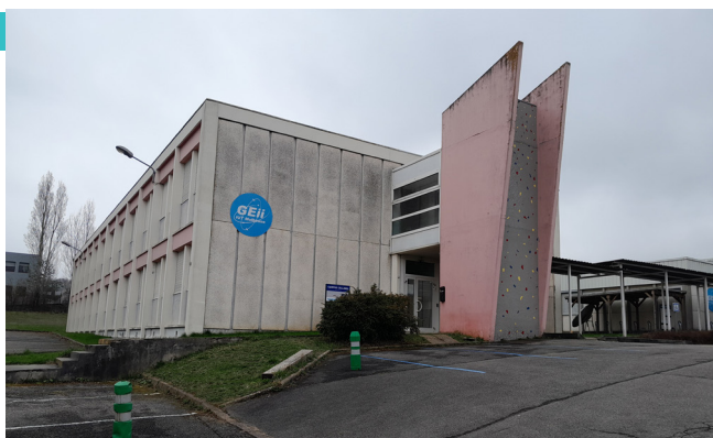
Bât.A : Salles de cours
