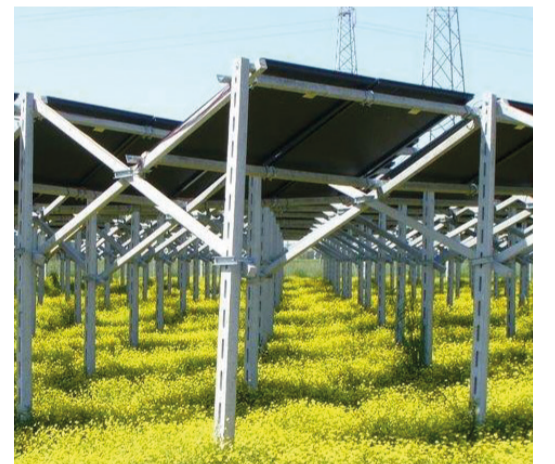
L'agritovaisisme, une technologie qui protège les cultures agricoles des aléas climatiques, tout en produisant de l'énergie
