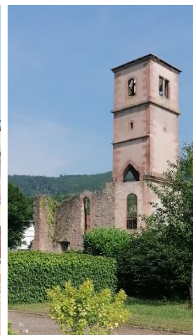
Leimbach – Les ruines de l'église Saint-Blaise.
