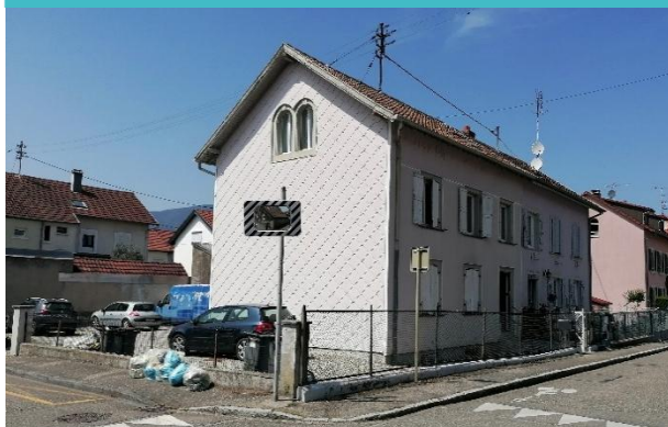
A Cernay le centre ancien est entouré de plusieurs cités ouvrières, composées de bâtiments réalisés selon un plan type, mais qui ont été modifiés avec le temps.
