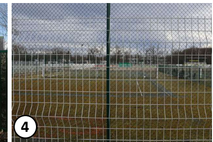
4 Une juxtaposition de grillage cloisonne les divers équipements sur tout le site
