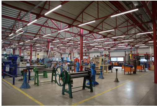
L'intérieur du bâtiment chaudronnerie (C) : de grands volumes en bon état
