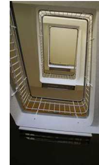
Escalier de l'internat, seul moyen d'accéder aux étages supérieurs (B.1)
