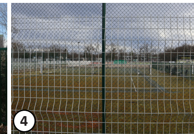
4 Une juxtaposition de grillage cloisonne les divers équipements sur tout le site
