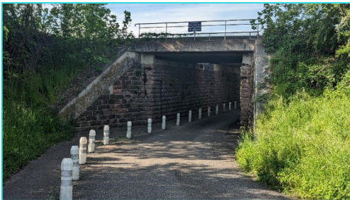
Les défis du franchissement des voies ferrées par les pistes cyclables (passage inférieur rue de Lattre de Tassigny).
