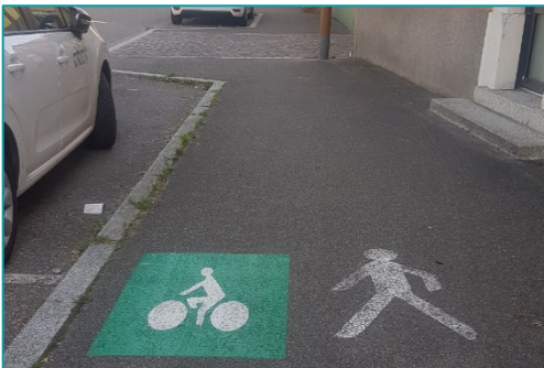
Trottoir partagé rue Braun : cette solution n'est pas adaptée à tous les cas de figure, par exemple en cas de forte affluence piétonne et cycles, sauf à adapter la largeur des trottoirs en conséquence.
