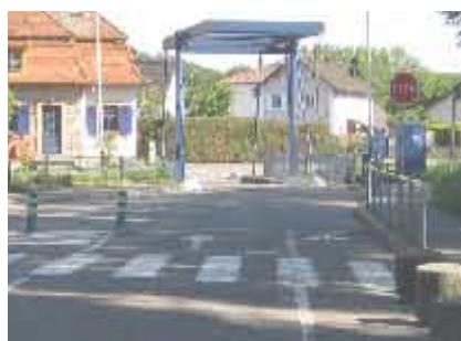
Pont-levis aménagé de façon à séparer les flux piétons des flux des véhicules.
