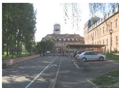
Entrée principale dans l'enceinte du collège pour les bus qui se rendent à l'arrière du collège.
