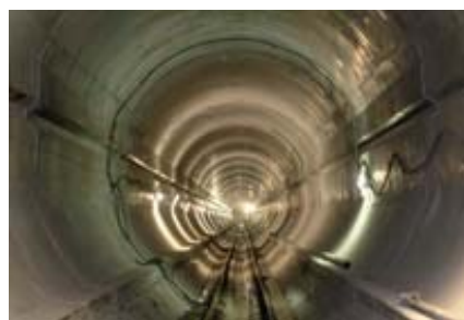
Galerie de secours (Source www.vicat.fr)
