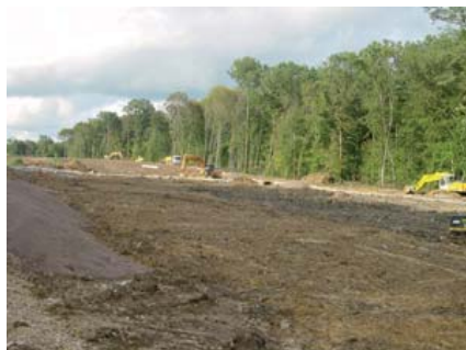
Travaux de déviation de Lure (Source : site RN 19)
