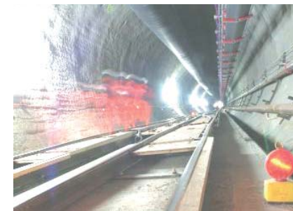
Travaux tunnel de base du Saint-Gothard (galerie) Source : site Alptransit
