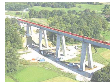
Ouvrage d'art en cours de construction sur la LGV Rhin-Rhône (Source : RFF)
