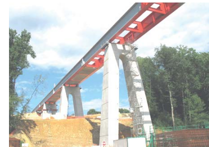
Ouvrage d'art en cours de construction sur la LGV Rhin-Rhône (Source : RFF)
