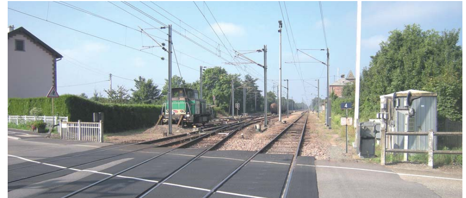
Voie ferrée Mullhouse / Chalampé à hauteur de l'ancienne gare de Bantzhenheim
