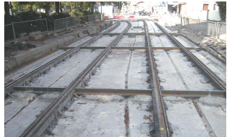
Travaux de plate-forme tramway en 2008, quartier de Bourtwiller
