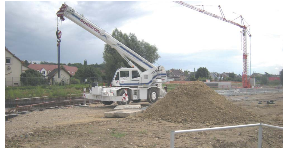
Travaux de dénivellation du PN 3 de Brunstatt, point de connection ouest de la Voie Sud
