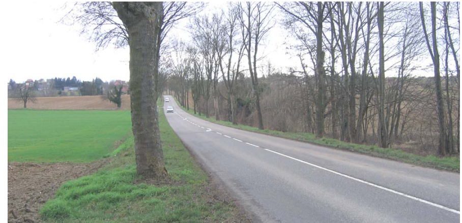
RD 21 entre Bruebach et Mulhouse
