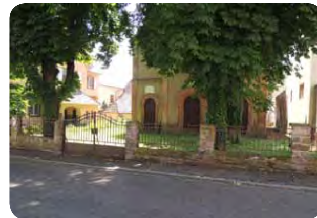
La synagogue est un des bâtiments repérés par le sentier du Patrimoine
