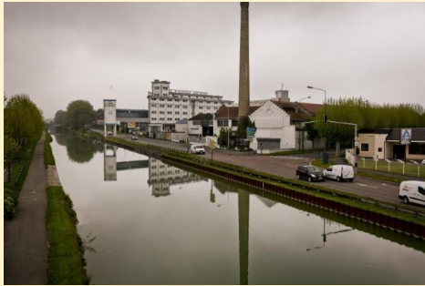
Le site de Port Colbert, friche industrielle en cours de reconversion résidentielle, crédit photo : L'Union
