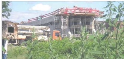
Les travaux du raccordement court été 2010
