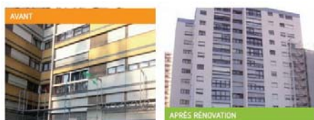
Mise en oeuvre du PICO- source : Energivie
