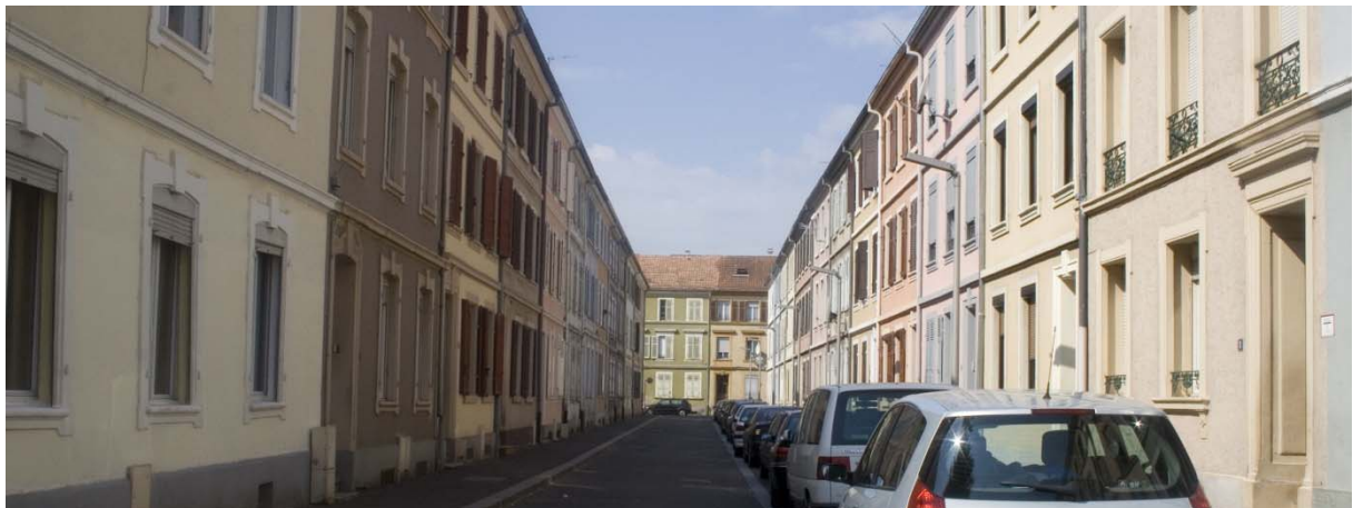
Rue des Maçons - Paul Kanitzer - 2009
