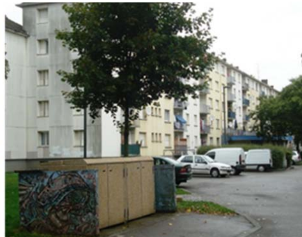
Voie de desserte depuis la rue de la navigation
