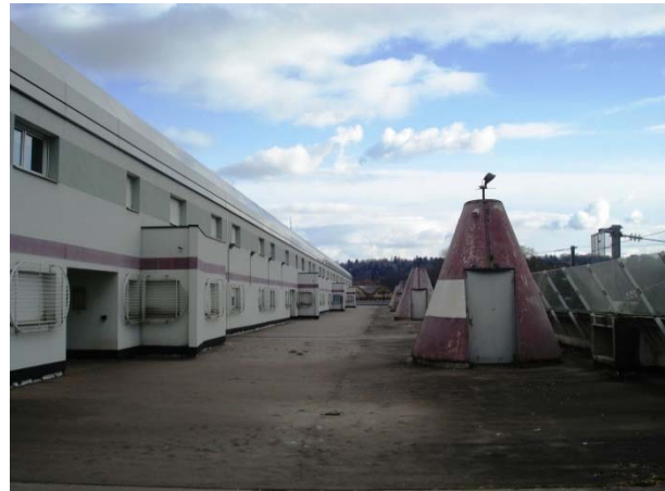
L'accès aux logements depuis la dalle de parking
