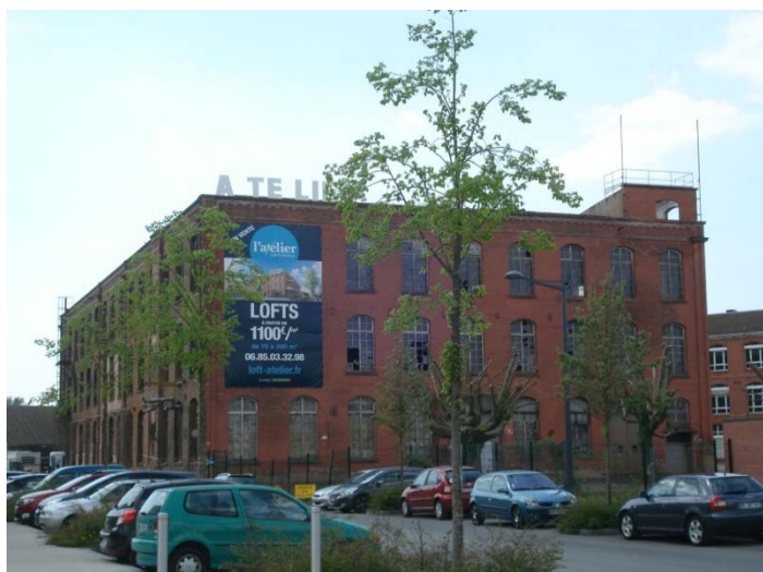
Ancien bâtiment d'activité destiné à l'aménagement de lofts
