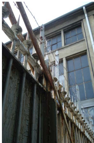
Ancien accès au site, à l'angle des rues St-Michel et St-Sauveur.
