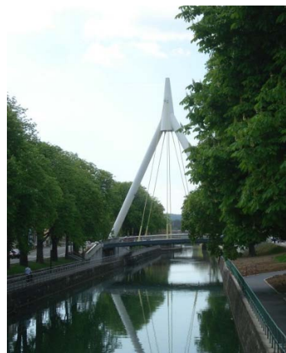
Le quai d'Isly et le nouveau pont de la Fonderie
