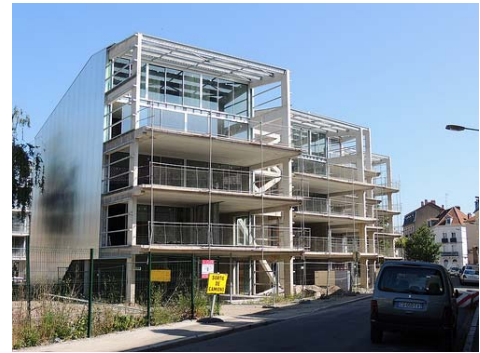
Les logements de la SOMCO, rue Neppert
