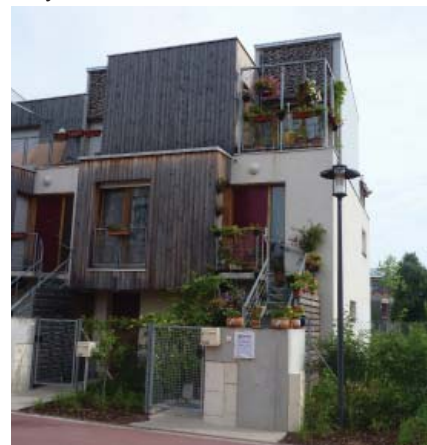
Des logements sociaux dans le quartier Wagner, à Mulhouse.
