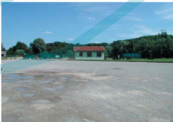
Esplanade non aménagée, en arrière-plan les terrains de tennis
