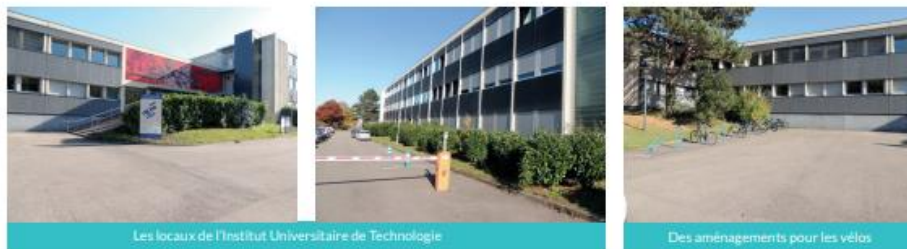
Les locaux de l'Institut Universitaire de Technologie
