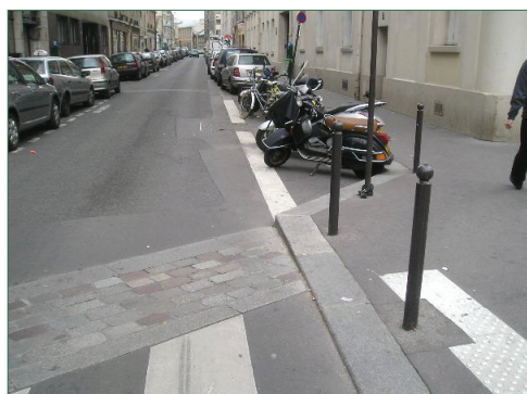
Paris (75) : une avancée de trottoir couplée à une surélévation de chaussée.
