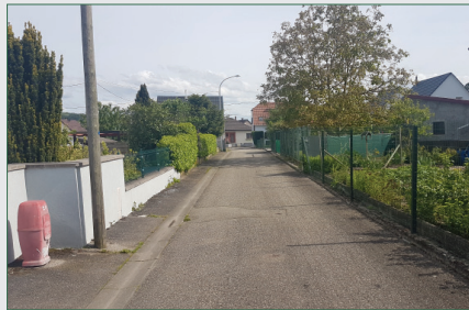
Niffer : absence de trottoir, les piétons marchent sur la chaussée.
