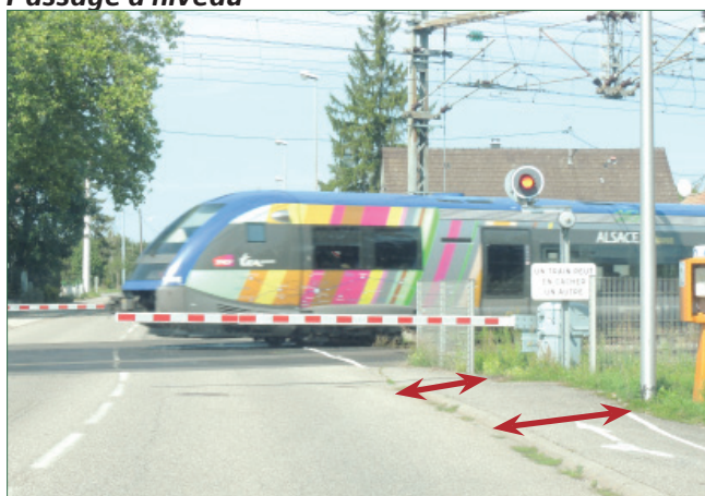
Passage à niveau
