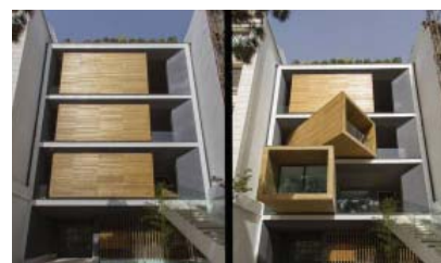
Un cabinet d'architectes iraniens a conçu un immeuble à blocs rotatifs à ouvrir ou fermer en fonction de la température extérieure. C'est une réponse pour limiter la climatisation mécanique dans les îlots de chaleur urbains. (Illustration : © Salar Motahari)
