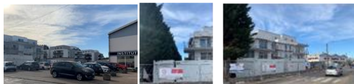
Garennnes nord : en cours de construction, 3 collectifs sur un ancien parking
