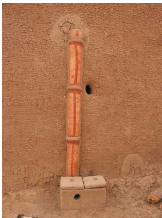
Exemples d'assainissement à Djenné
