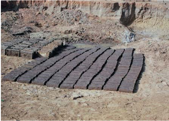
Séchage des briques
