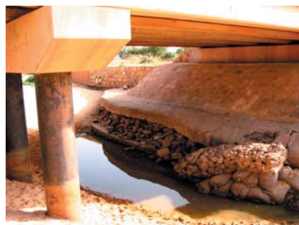
Le pont de la RN 6
