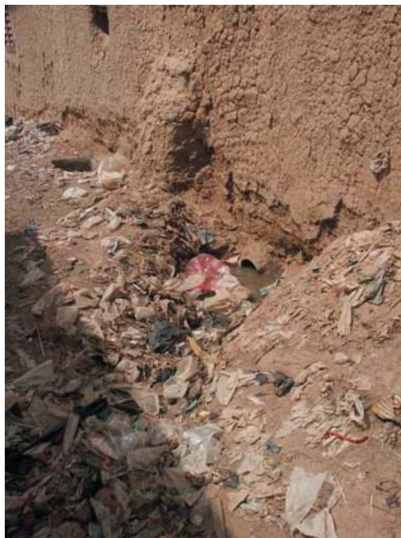
Aucun dispositif d'assainissement actuellement
