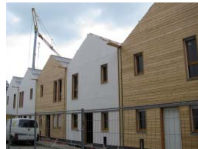
Maisons Elika - constructions en bois Crédit photo : Ville de Mulhouse
