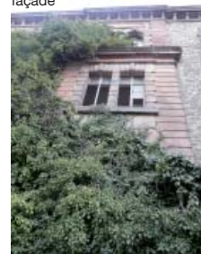
Caserne Lefebvre détail de façade
