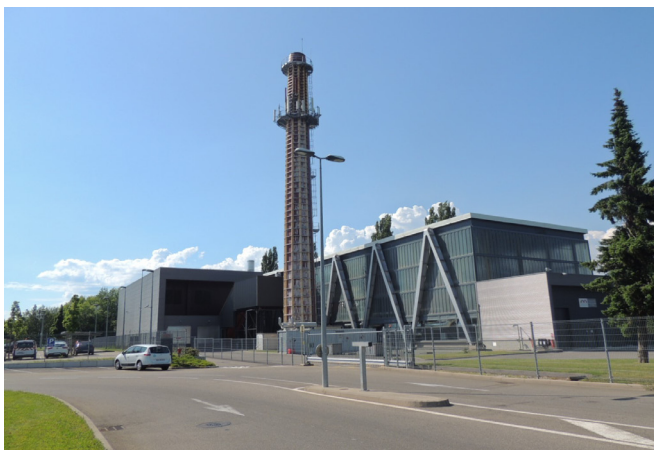
La centrale thermique de l'illberg aujourd'hui reliée au Groupe Hospitalier de la Région de Mulhouse et Sud Alsace (GHRMSA) Sources : AURM
