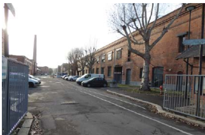
Le bâtiment 48 de DMC est pressenti pour accueillir ce projet de filière « de la terre à l'assiette».
