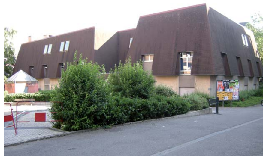
Bibliothèque centrale Grand'rue
