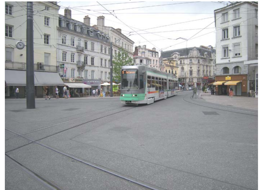
Au coeur du centre-ville, le croisement des 2 lignes de tramway
