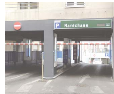
Parking des Maréchaux, Mulhouse
