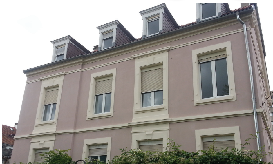
Rue des Noyers, à Mulhouse, une maison de ville a été rénovée grâce au système du bail à réhabilitation.
