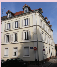
l'immeuble après travaux
