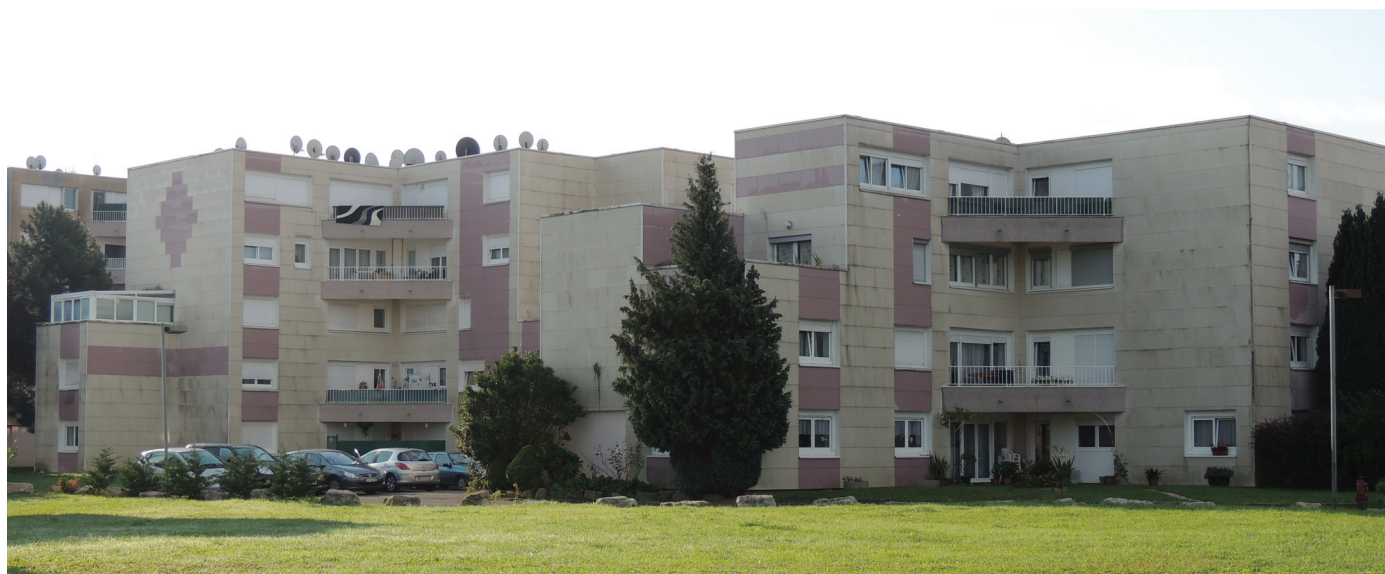
Les copropriétés la Forêt I et II, à Wittenheim, cumulent des problèmes administratifs, techniques et financiers.
