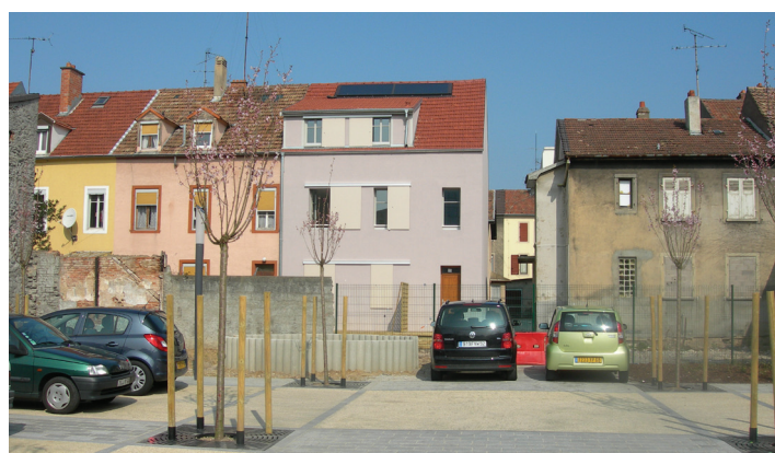
Vue sur l'arrière d'un des immeubles rénovés «basse énergie». En toiture, les panneaux solaires sont bien visibles. La façade arrière et le pignon ont été isolés par l'extérieur.
