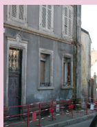
l'immeuble avant travaux
