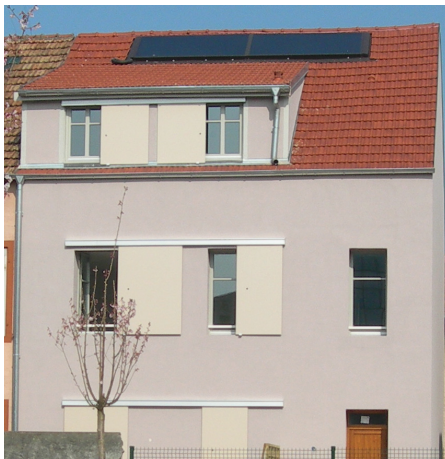
Dans le quartier Franklin, certains immeubles de l'ORI ont été rachetés par des investisseurs avec l'obligation d'en faire des logements très performants sur le plan énergétique.
