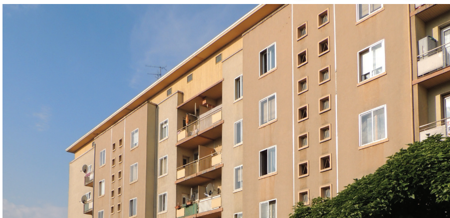
A Allzach, la copropriété Construire est considérée comme une copropriété fragile.
