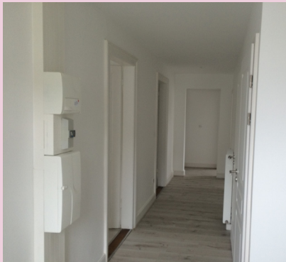
Un des appartements rénovés.
