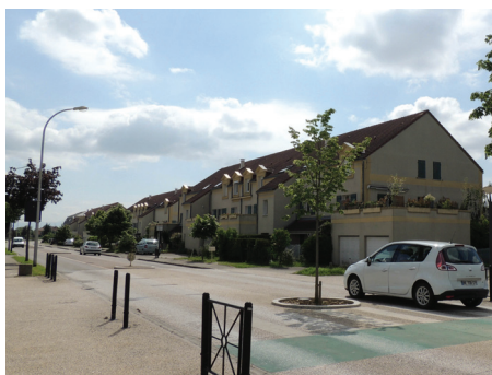
Logements intermédiaires en front de la rue Debussy
