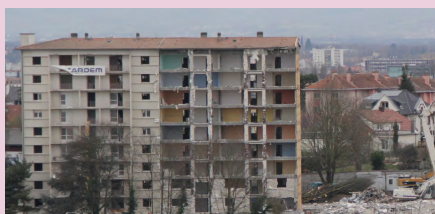
Le Bloc Lorraine démolit au printemps 2015 fait place au nouveau projet (source : Riedisheim)
