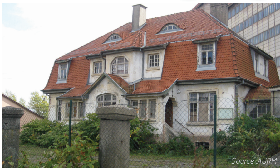
Un bien délaissé au détriment de sa valeur architecturale et résidentielle (Wittenheim)
