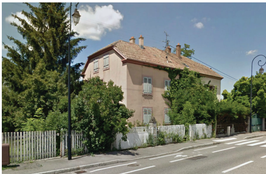
Deux maisons mitoyennes, préemptées, qui seront démolies pour laisser place à une petite opération de 8 logements sociaux (photo : Google maps, 2013)
