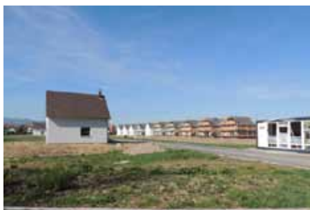
Urbanisation en cours du secteur Melkery à Bollwiller : une zone qui a fait l'objet d'OAP dans le POS pour encadrer un projet résidentiel mixte
