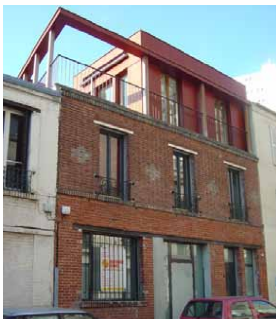
Augmentation du volume et de la superficie construite - Rue de la Durée, Paris
