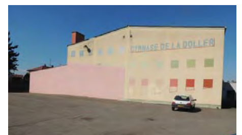
Le gymnase de la Doller est de qualité médiocre. Il nécessite une rénovation importante, notamment au niveau thermique
