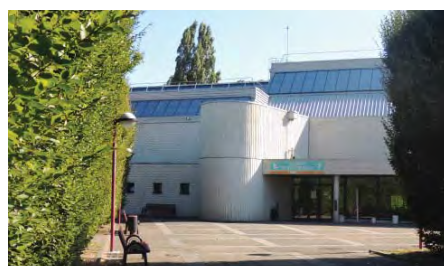
La salle de gymnastique est très utilisée par les scolaires et reste d'usage très spécialisé
