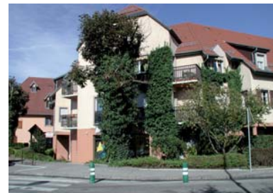
Petit collectif au centre du village de Zimmersheim comportant des commerces en rez-de-chaussée (pizzeria, tabac). Des dispositifs architecturaux atténuent la perception de la densité.
