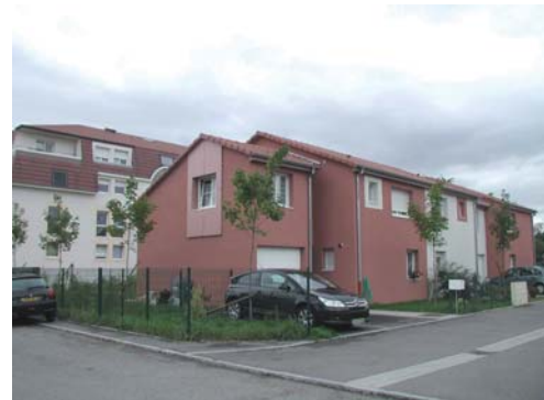
Maisons individuelles groupées à l'avant d'un immeuble collectif en R+1+C : des gabarits similaires assurant une bonne transition.
